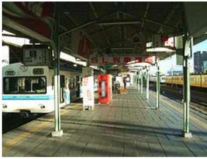
秩父鉄道熊谷駅の画像検索より
